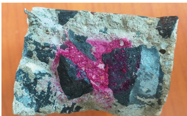
7. ábra. M7 gyorsbeton tört felülete (Fotó: Szentpéteri, 2019)
