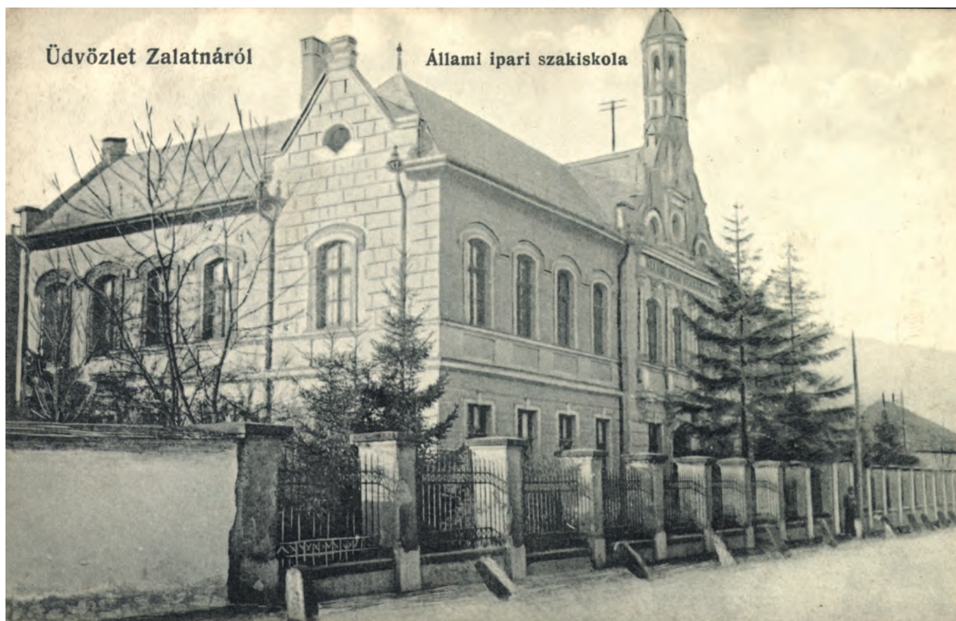
1. kép. Az iskola épülete, 1895 után. Korabeli képeslap
