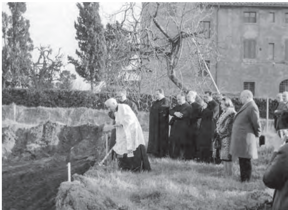
48. Első kapavágás a római Szent István Ház építéskor – 1966
