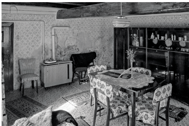
49. kép. A nagyszoba gázkonvektoros fűtéssel, 2002.
