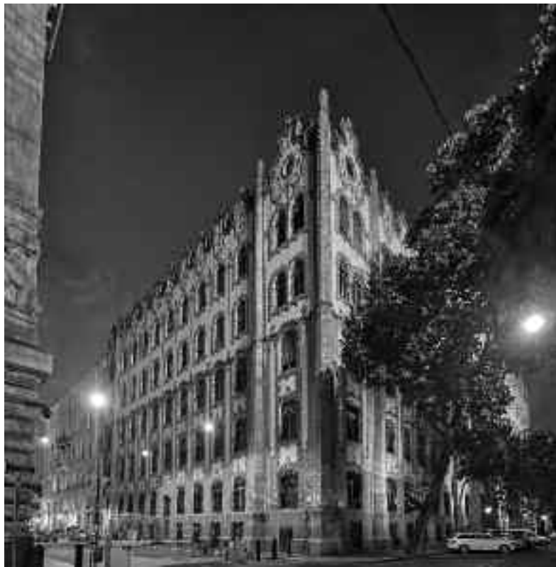
Lipótváros. A Postatakarék- pénztár, ma Nemzeti Bank épülete
