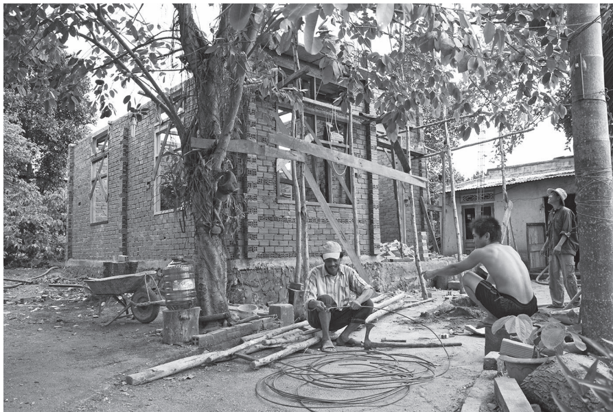
7. kép. Az épülő új ház
