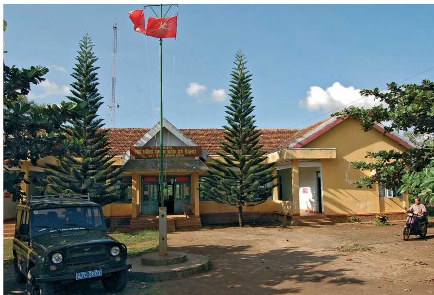
III. kép. A járásközpont épülete
