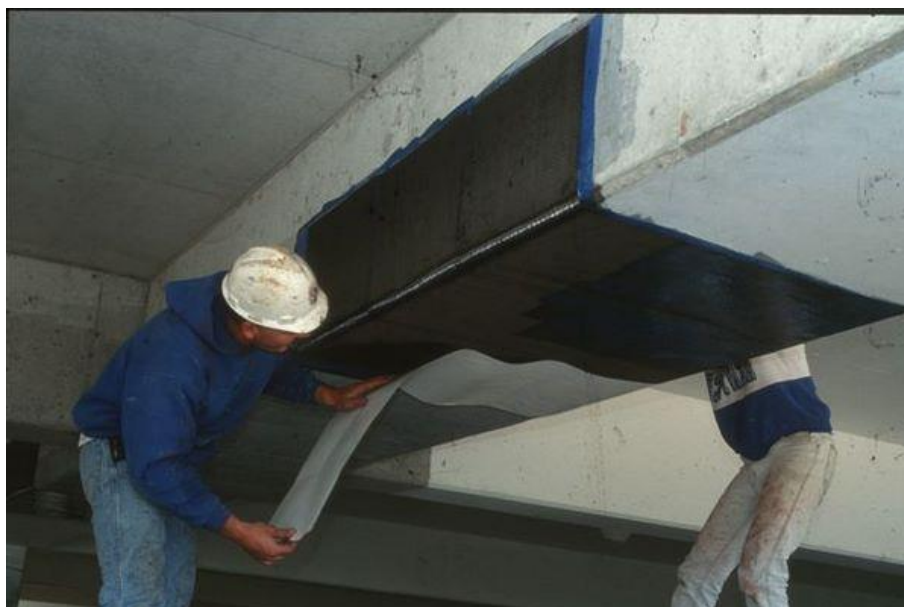
36. ábra. Tartószerkezet megerősítés szénszálas anyaggal [18]
