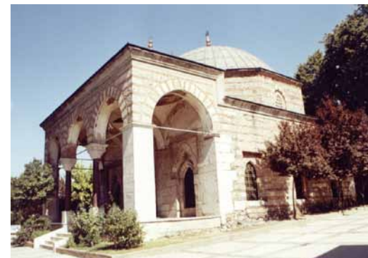
Az I. Murád szultán alapította épületkomplexum fővárosában, Burszában
