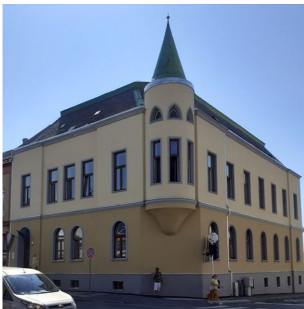
6. kép Az épület homlokzata a 2022-es felújítás után (A szerző felvétele)
