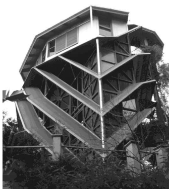
8. ábra – Az alsó három szint külső falaira kitülő, hullámlemez borítású negyedik szint
