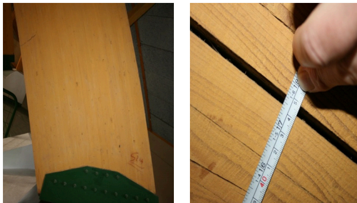
1. ábra A harkányi tornacsarnok vékony lamellás ép és vastag lamellás repedt tartói
