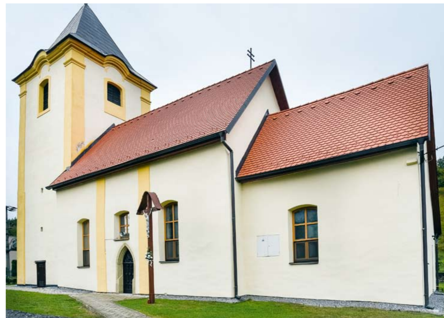
← 1. Periodizált alaprajzi vázlat a sekrestye átépítése előtti állapotról ← 2. A szentélybelső boltozattal 3. A templom délkeletről
