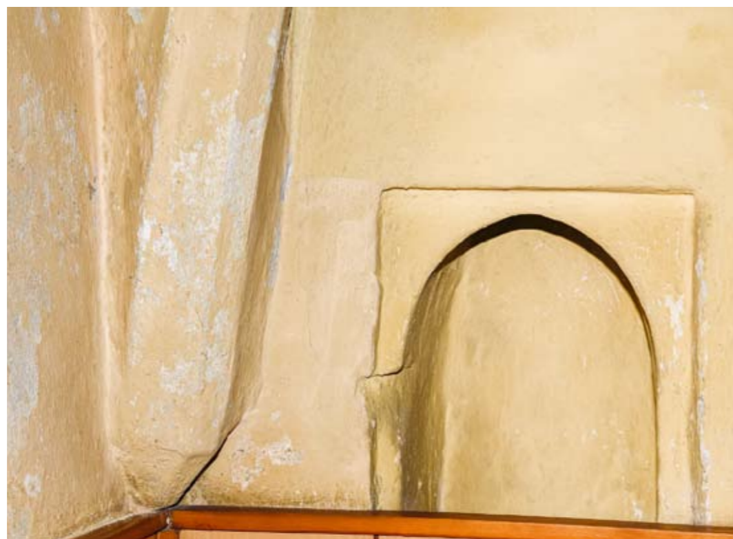
3. A templombelső nyugatról 4. Szentségfülke és bordaindítás a szentély északkeleti sarkában
