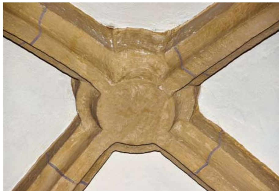
3. A déli kapu timpanonja 4. Zárókő a szentélyben 5. Boltozatindítás a szentélyben
