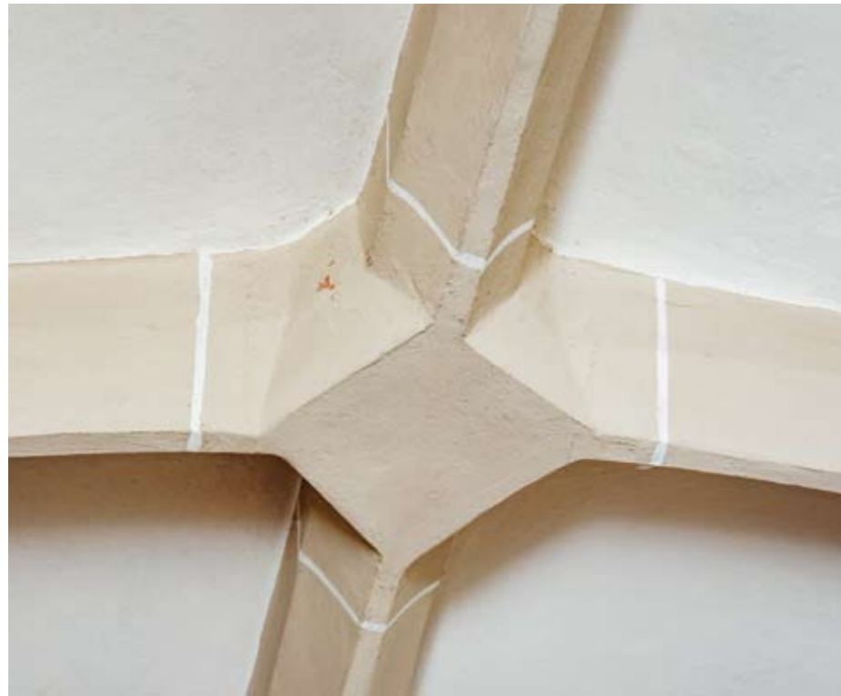
5. A szentélyboltozat a zárókövel 6. Konzol a szentélyben
