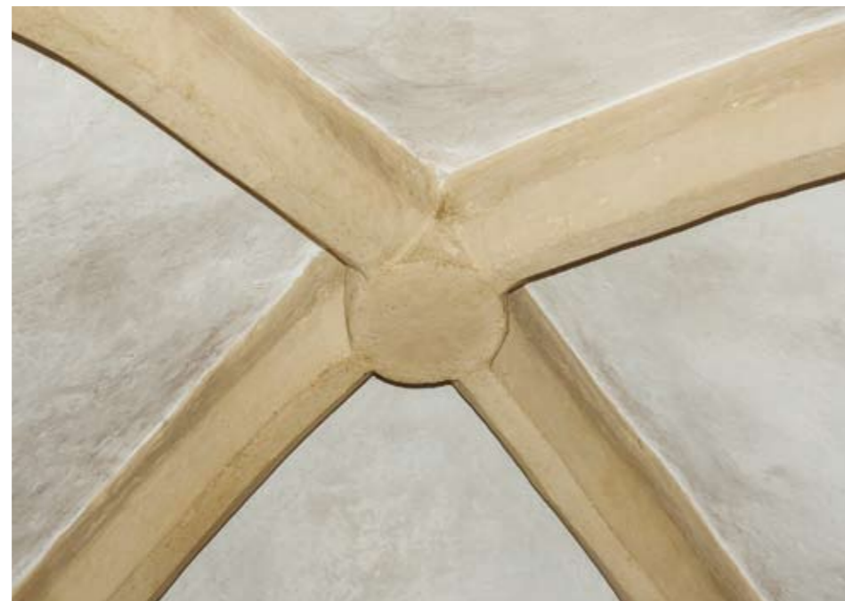
3. A templombelső nyugatról 4. Bordaindítás a szentélyben 5. A szentély záróköve
