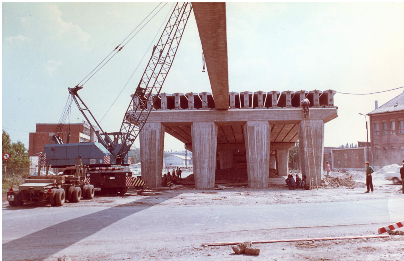
Mi épült 50 éve, 1973-ban: Előregyártott, utófesztített, vasbeton hídgerenda beemelése Pécsen
