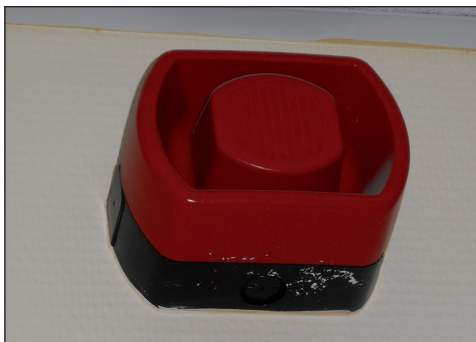
2. ábra: Hangjelző (a szerző felvétele)
