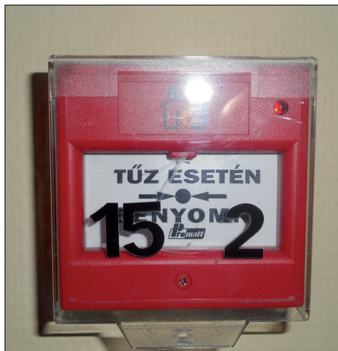
4. ábra: Kézi tűzjelző (a szerző felvétele)
