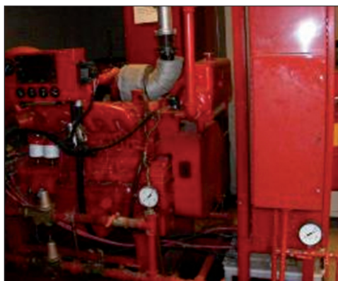
6. ábra: Tűzvízszivattyú (a szerző felvétele)
