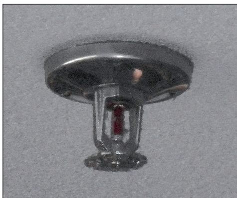
7. ábra: Spinklerfej (a szerző felvétele)
