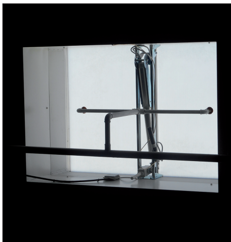
5. ábra: Hő- és füstelvezető ablak (a szerző felvétele)
