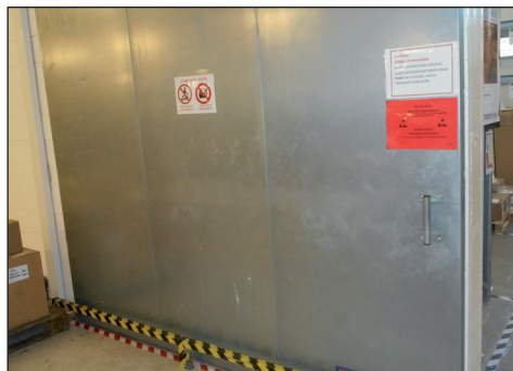
3. ábra: Tűzgátló kapu (a szerző felvétele)
