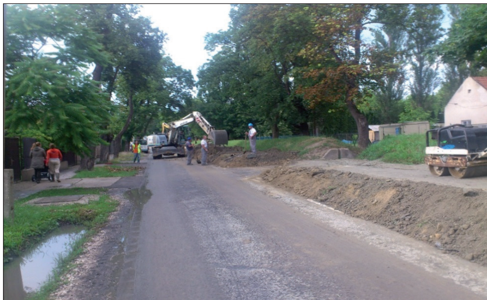
3. ábra: Védmű építése (készítette: Morvai Cintia, 2013, Római-part)
