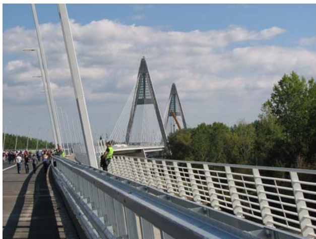
A fővárost elkerülő M0-as autópályát északi láncszeme a Megyeri híd. A lakott területhez közelebbi szakaszán zajfogó üvegfal is van. (Fotó: Marosi Lajos)
