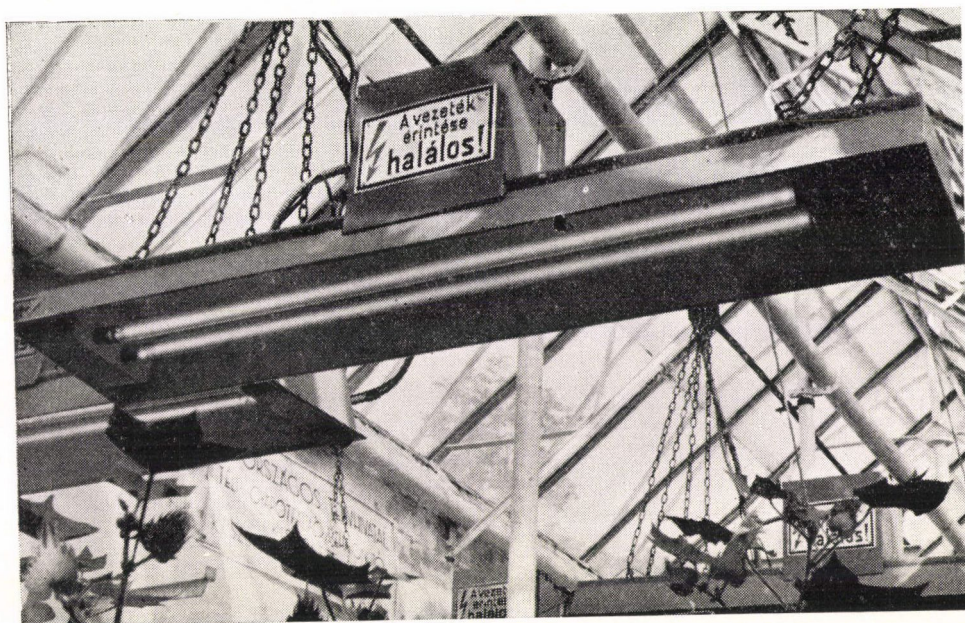
3. kép. A gyapotház egy világítótestének képe. A koporsófedélhez hasonló ernyő alatt jól látható a két világítócső. Régius János felvétele.
