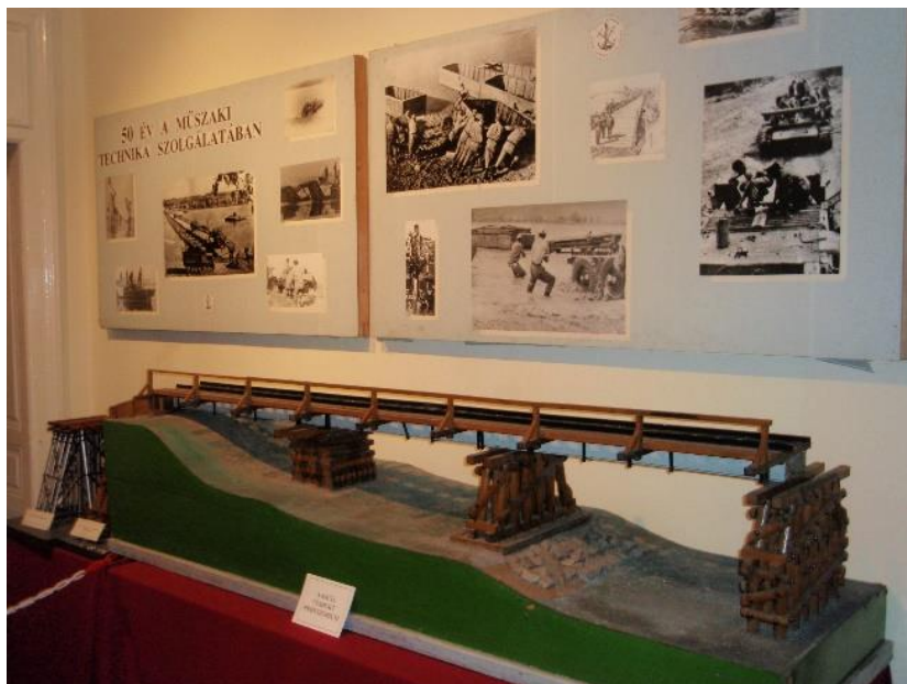
7. számú ábra. Vasúti viadukt provizórium
