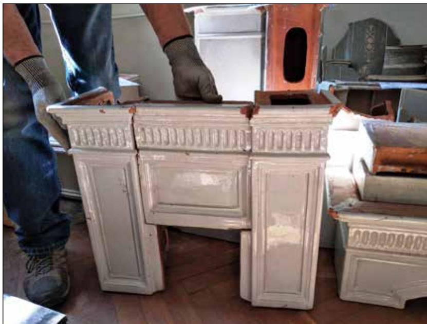
35. Rekonstrukciós javaslat: svéd rendszerű táblás kályha T36-os feliratozással, rekonstruálható (lelt.sz. IP.2020.45.)
