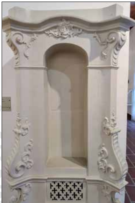
19. Svéd-rendszerű neobarokk cserép-kályha, részlet (lelt.sz. IP.66.158.1.; a szerző felvétele, 2021)
