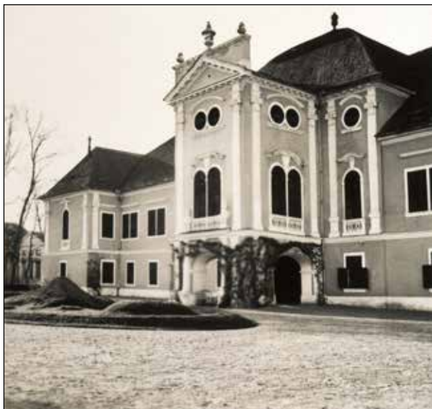
9. A Forgách–Lipthay-kastély timpanonos üvegházzal 1939-ből (Fortepan – képajándékozó: Buzinkay Géza)
