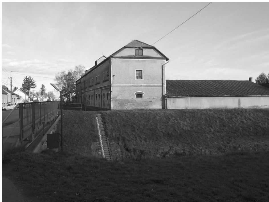
1. kép: Az egykori Columbia Bőrgyár épülete, 2015 Forrás: Németh Sándor felvétele Az épületben a bőrgyár bezárása után malom működött, amely 2010-ben végleg bezárt és jelenleg üres az ingatlan.
