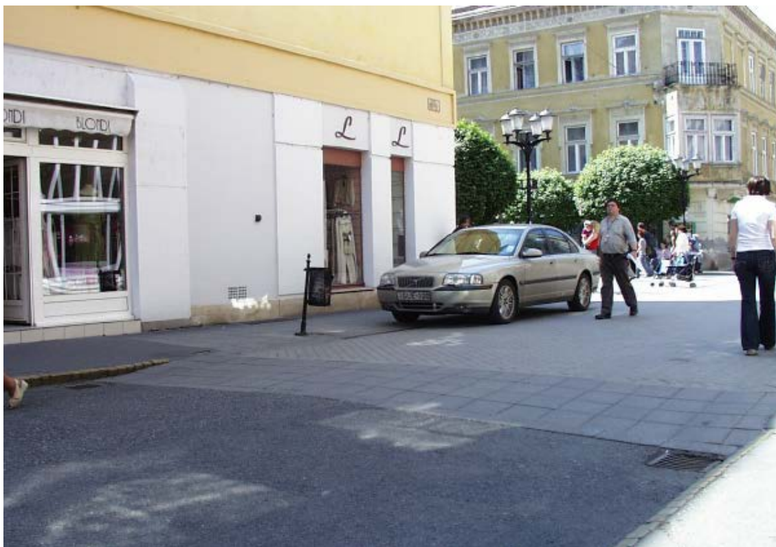
2. ábra: Forgalmcsillapítás szintemeléssel
