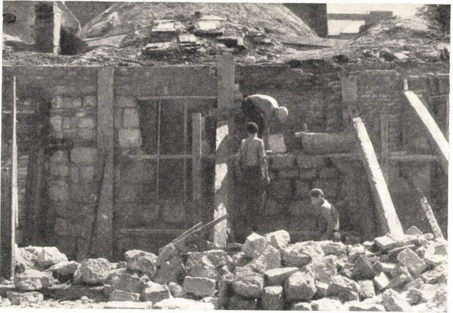
22. kép. A törökkori falak tönkrement részleteinek pótlása
