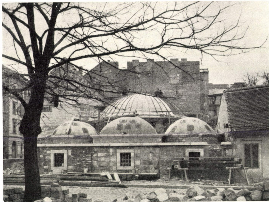
21. kép. Készül a kupolák vörösrézfedése
