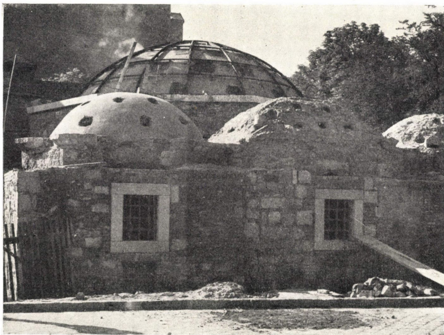
17. kép. A kupolák rézfedésének előkészítő munkálatai (A kiskupola extradósán cementsimítás, a nagykupolán készül a rézbádogot hordó fa bórdázat)
