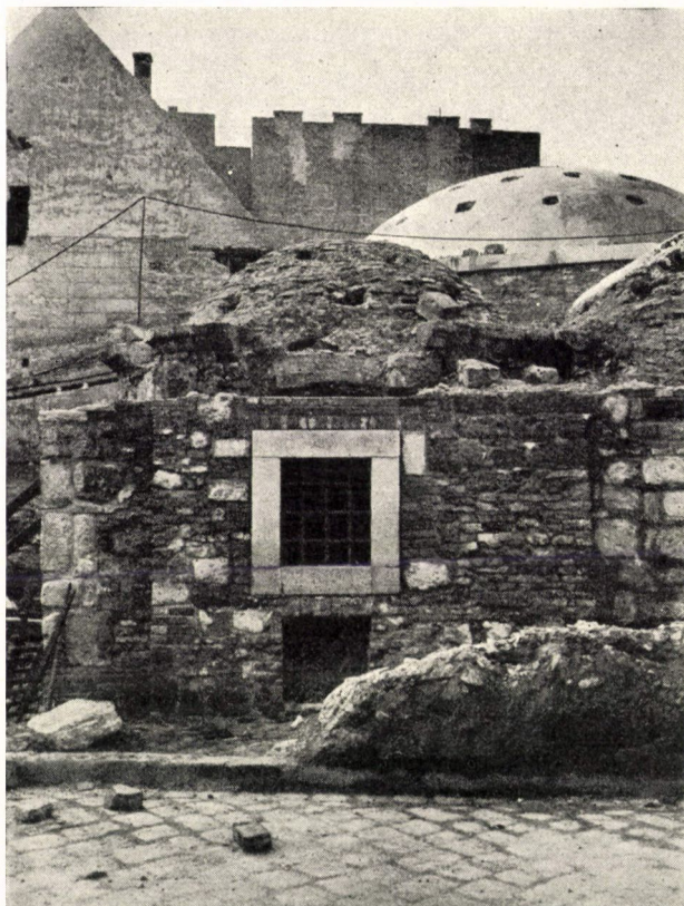
13. kép. A kis kupolatér ablaka helyreállítva
