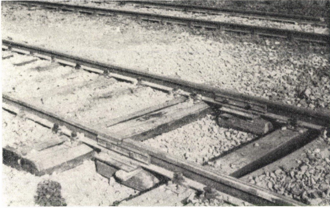
1. sz. ábra: A sínvégek ideiglenes összekötése
