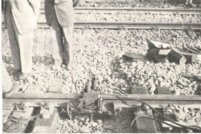
4. sz. ábra: A sínvégek melegkezeltése
