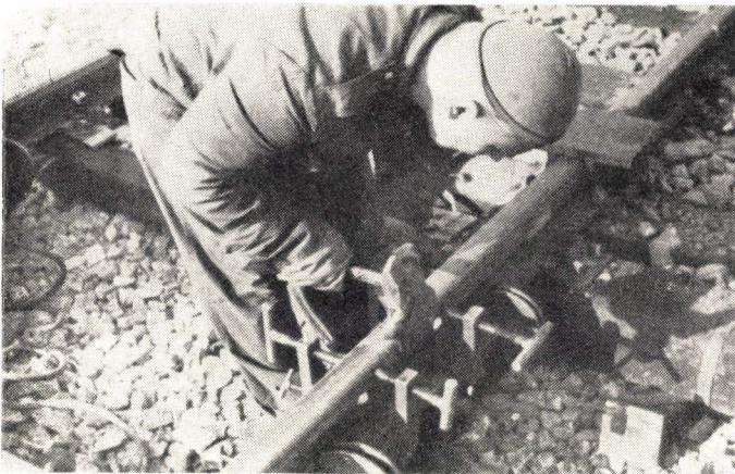
3. sz. ábra: A hegesztett sínfejek megdolgozása
