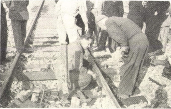
4. sz. ábra: A sínvégek melegkezeltése
