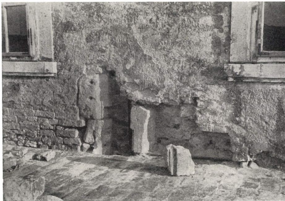
13. kép. Gótikus ablakmaradvány az északi homlokzaton
