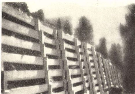
7. ábra. Háttöltésbe horgonyzott támfal
