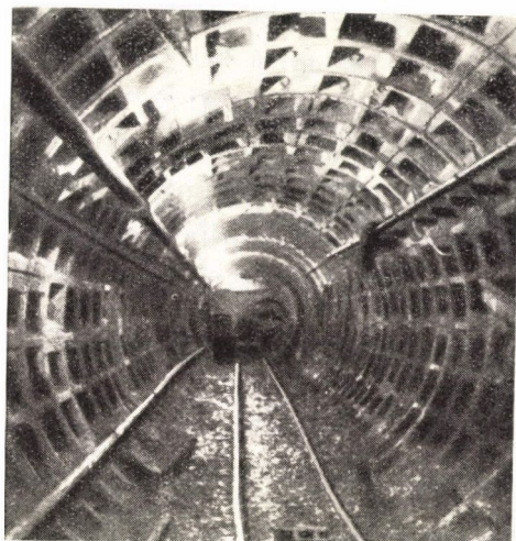
12. ábra. Alagútépítés vasbeton-bélésgyűrűkkel
