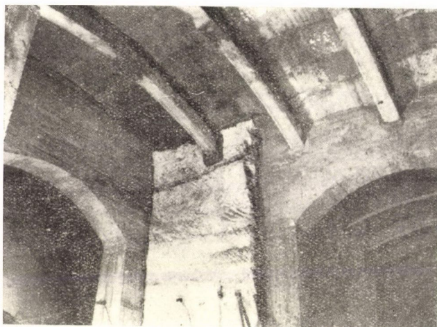
2. ábra. A Maglói úti pince megerősítése
