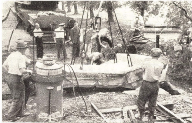
2. ábra. Építés beemeléssel
