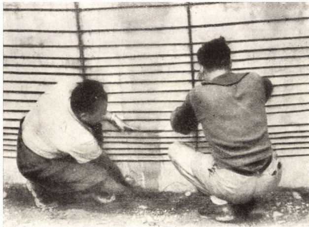
7. ábra. A hengerfal feszítése
