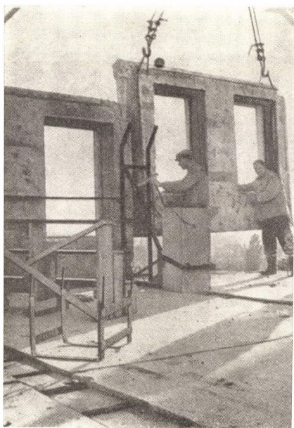
12. ábra. Falelemek szerelése
