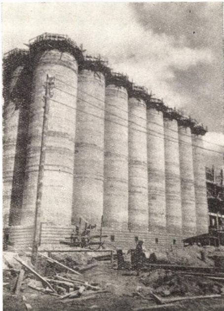
15. ábra. Siló építése csúszózszaluzattal IPARI TERVEZŐ IRODA, WAR-SZAWA (Foto: C. A. F.)
