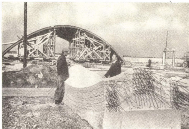
26. ábra. Hullámlemez-elemek előregyártása egymásra helyezett rétegekben (Foto: C. A. F.)
