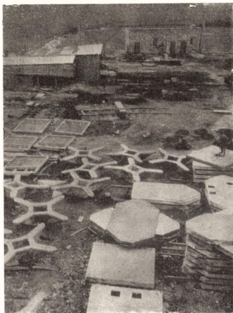
25. ábra. A gombafödém szerkezetének előregyártott elemei (Foto: ROBOWSKI)
