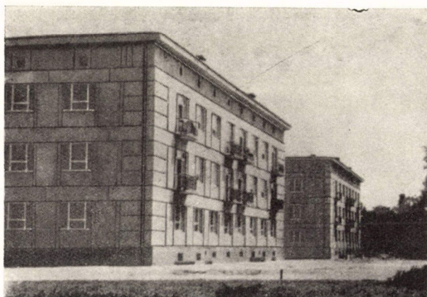
7. ábra. Nagymeretű falazó tömbökkel épített épület A. FOLTYN — A. TARCZEWSKI
