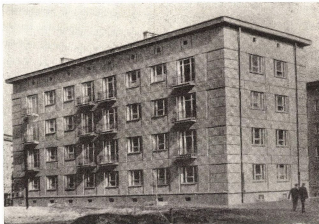
9. ábra. Nagy tömbökből falazott épület A. FOLTYN — A. TARCZEWSKI
