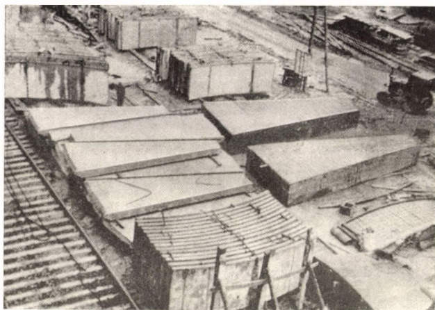
28. ábra. Siló előregyártott, feszített szerkezeti elemei az építés színhelyén St. KUS
