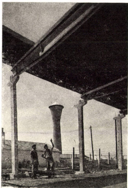
4. ábra. Gépállomási színek előregyártott tetőelemeinek szerelése
