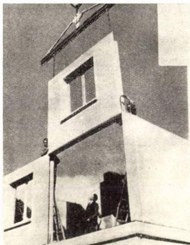
10. ábra. Lakóház szerelése (Coignet-rendszer)
