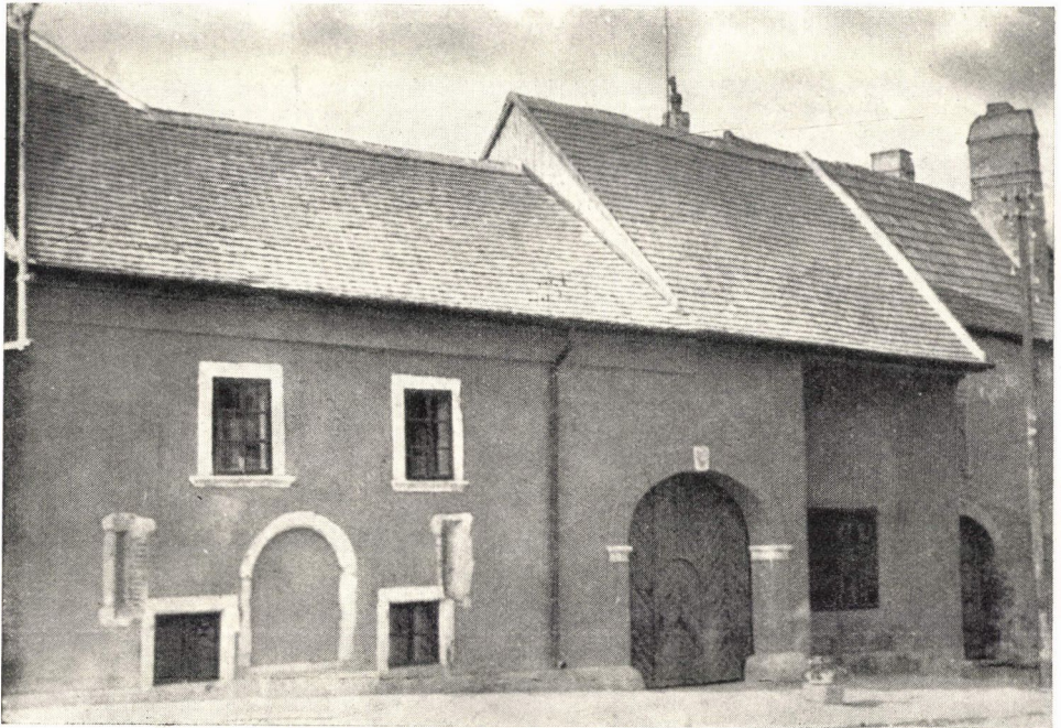
19. ábra. A soproni barokk ház helyreállítása során talált középkori részleteket is bemutatjuk
