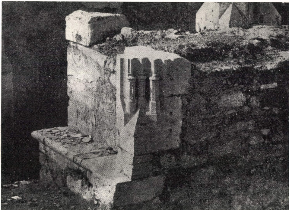
8. ábra. A feltárásokban értékes építészeti részletek, faragványok kerülnek elő. A Zsigmond-féle nagyterem „in situ” maradt ülőfülkés ablaka
