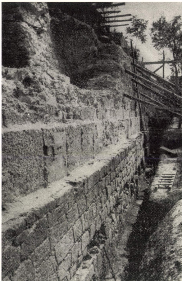
7. ábra. Régi várfalak helyreállítása a budai várban. Az átalakításokkal elrontott, 1944—45-ben sérült felületeket a föld alatt épen maradt részeknek megfelelően állítják helyre
