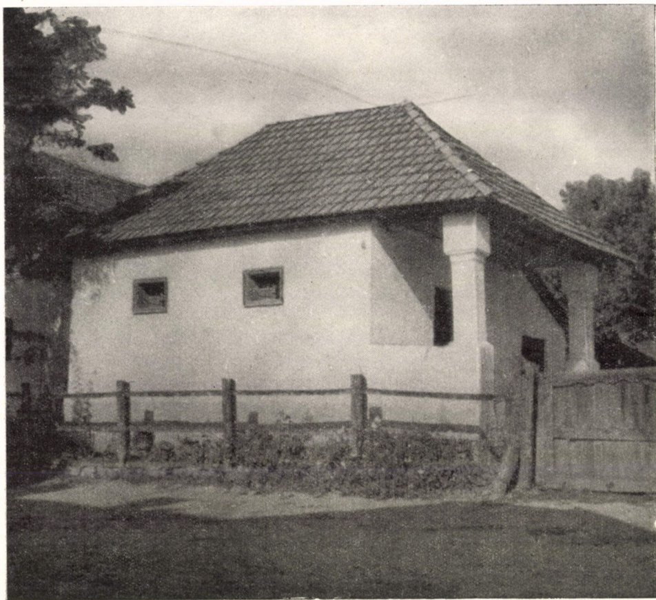
4. ábra. Gabonás. Szalonna, Borsod-Abaúj-Zemplén m. Egysejtű, rövidekeszes épület, téglafalazattal, vassinek közötti beton födémmel. Ép. : 1925. Dr. Vargha László felv.
