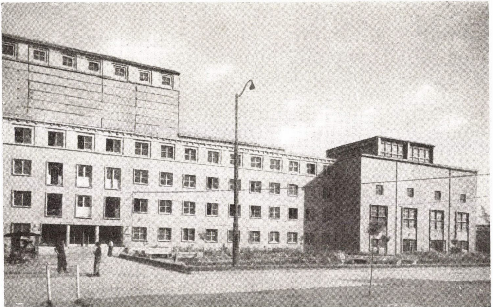
5. ábra. A Borsodi Erőmű bejárati épületének homlokzata
