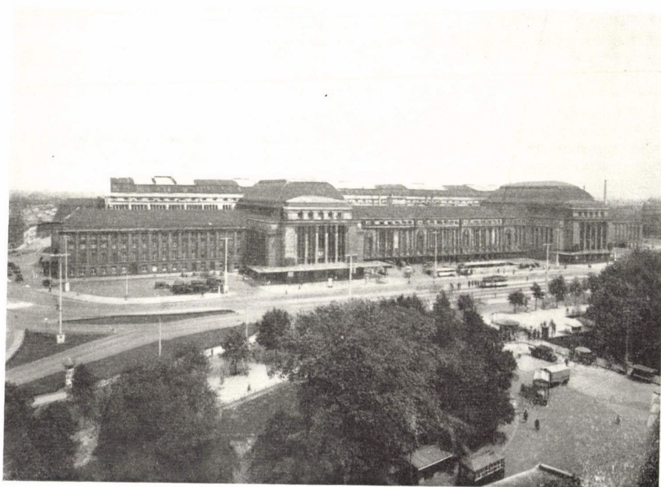
32. ábra. Lipse Hauptbahnhof. 1906/1916. (Lossow és Kühne terve.) Európa legnagyobb pályaudvarépülete
