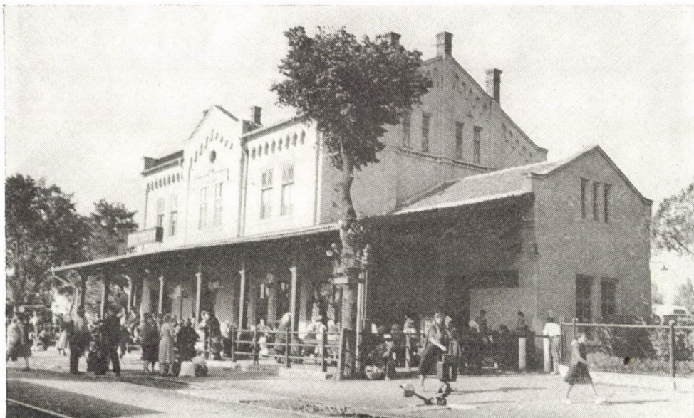
13. ábra. A Tiszavidéki Vasút típusépülete. 1858
