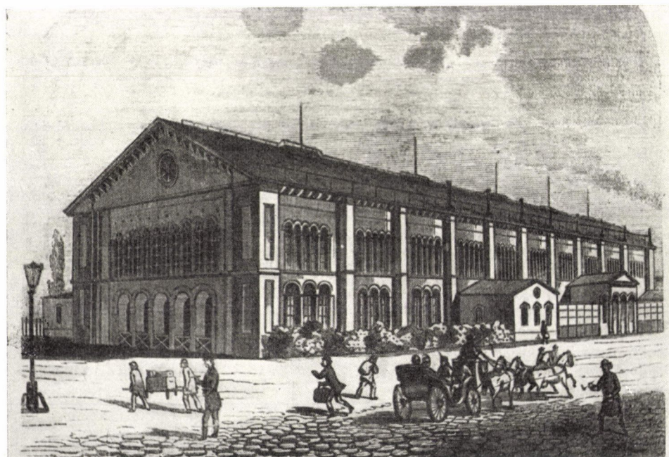
7. ábra. A régi Pest pályaudvar „indóháza”, a mai Nyugati pályaudvar helyén. 1846. (ifj. Zitterbarth Mátyás terve.) Az épületet a Nyugati pu. csarnokának elkészítése után bontották el
