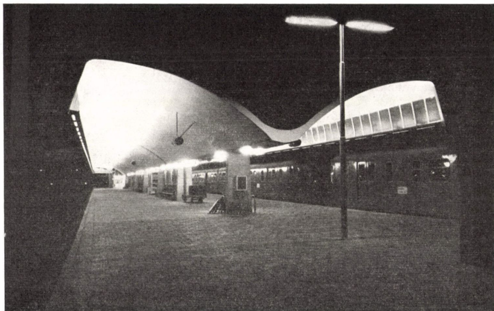
45. ábra. Rotterdam Centraal Station. 1958. (Ravesteijn terve)
