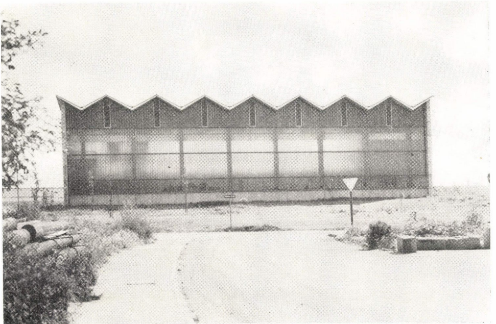
13. ábra. A Drezdai Szállítástechnikai Intézet (Institut für Fördertechnik der TU Dresden) lemezműves tetőszerkezete
