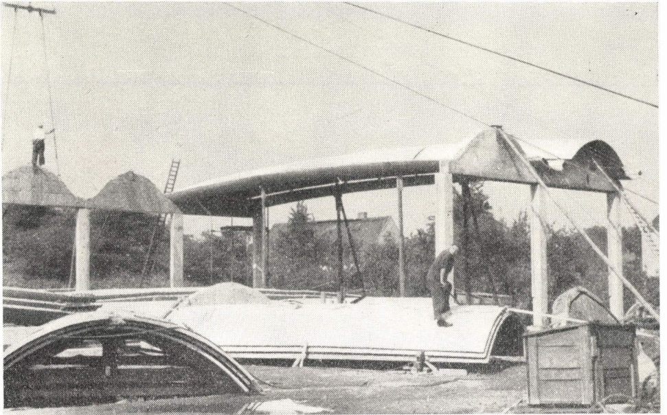
12. ábra. Beszerelt szélső mező
