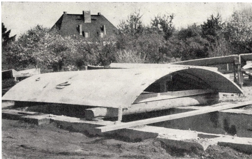
10. ábra. Felső héj előszerelése
