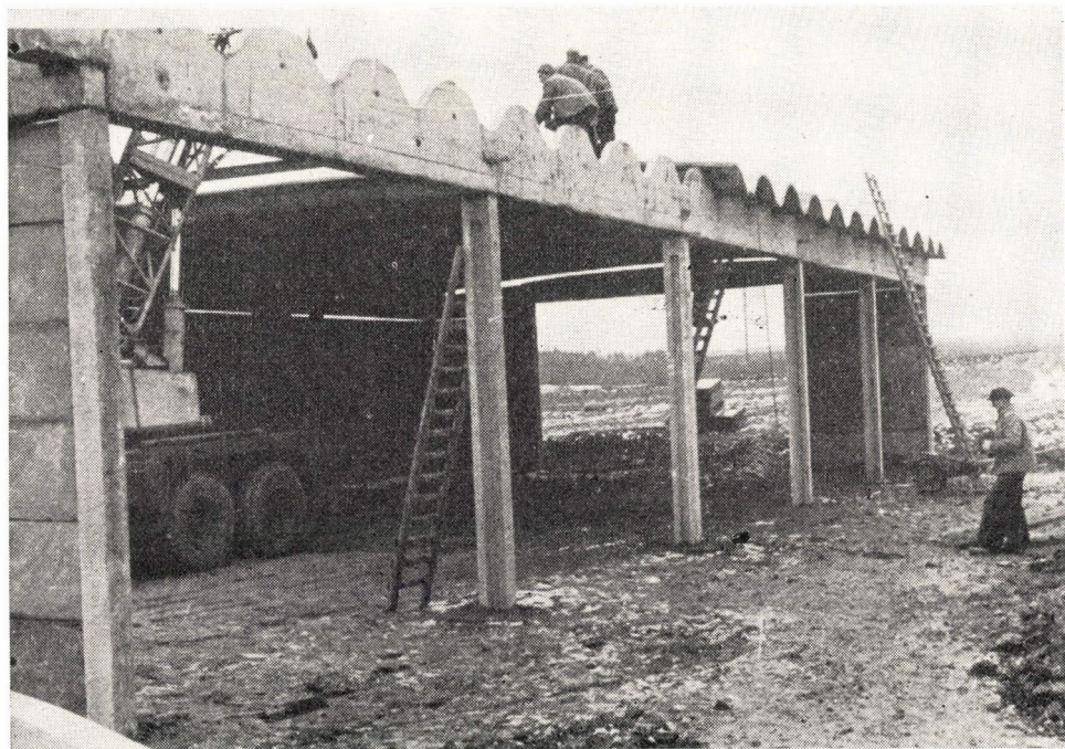
7. ábra. Hullámhéjtartók szerelése
