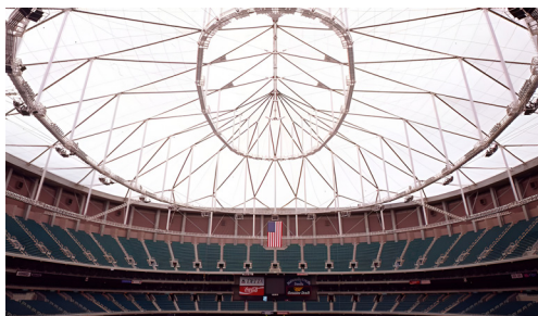
2. ábra. Georgia Dome kábelkupola tetőszerkezete (fotók – Birdair)
