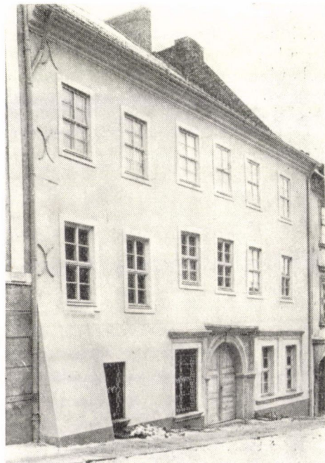
22. Straßenseite des Hauses Peterstraße 10 vor der Wiederherstellung. — A Peterstraße 10. sz. épület utcai homlokzata helyreállítás előtt
