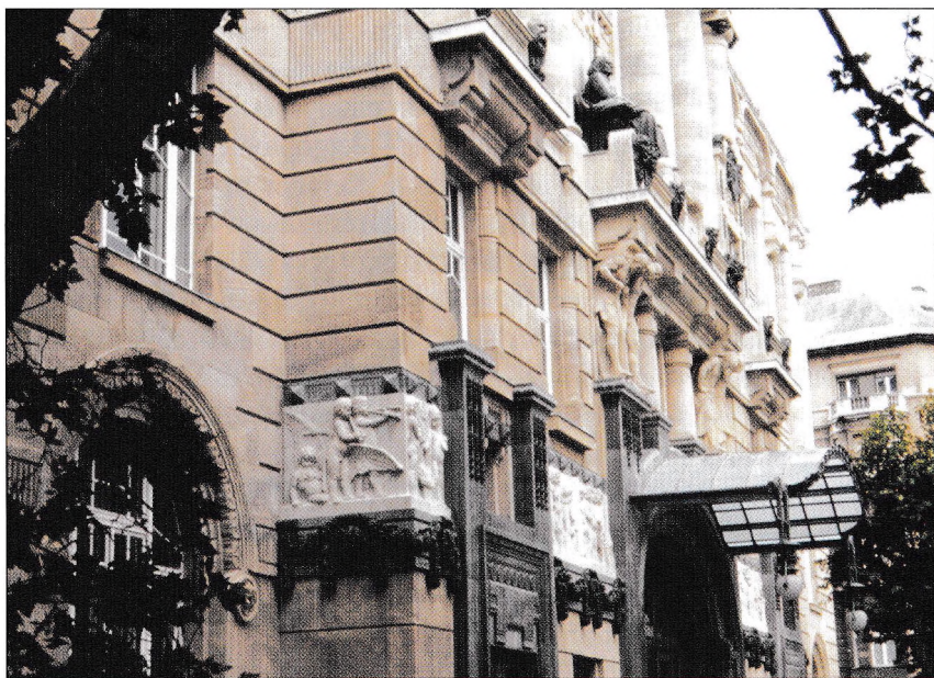
4. A főhomlokzat középrizalitjának részlete
