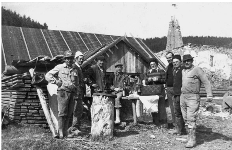
11. kép. Munkások a Lázár-kastély felújításakor. Forrás: Laczkó Szilveszter
