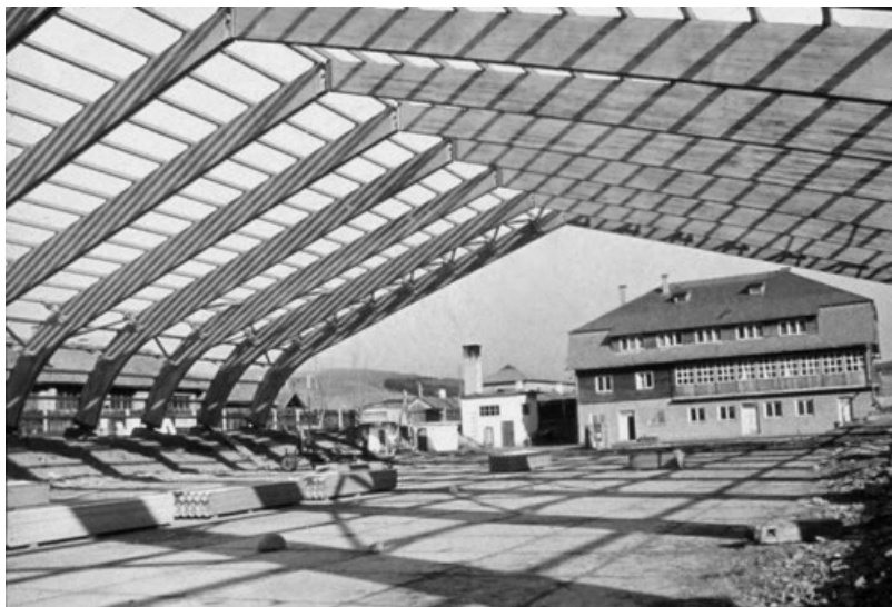
19–20. kép. A jégcsarnok építése. Forrás: DIA/Kozma Péter
