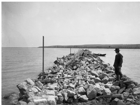
2. kép. Balatonföldvári nyugati móló építése, 1904–1905. Forrás: Fortepan 183522, orig. Magyar Műszaki és Közlekedési Múzeum / BAHART Archívum, Leltári jelző: MMKM TEMGY 2019.1.1. 1181.
