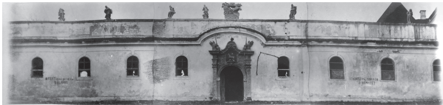
Fig. 36. Fațada nordică a fostului grajd în 1964, Fond DMI, dosar nr. 1144 bis.
