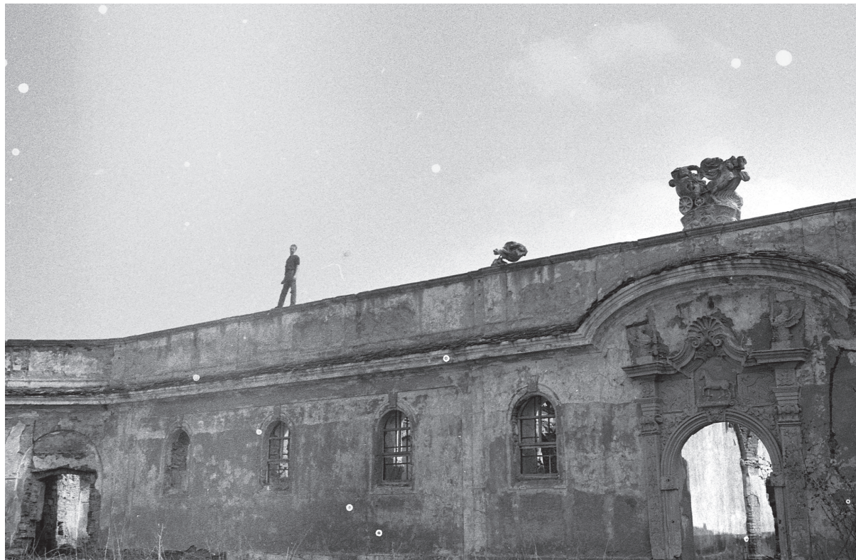
Fig. 51. Fațada nordică a grajdului în anii 1990, Kalló Angéla.
