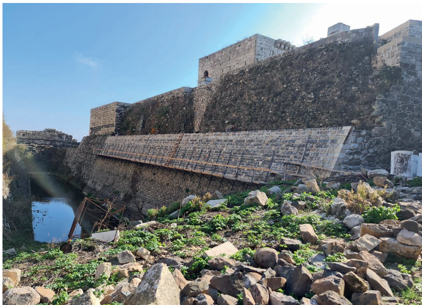
1. ábra. A Krak des Chevaliers lovagvár helyreállított támfala
