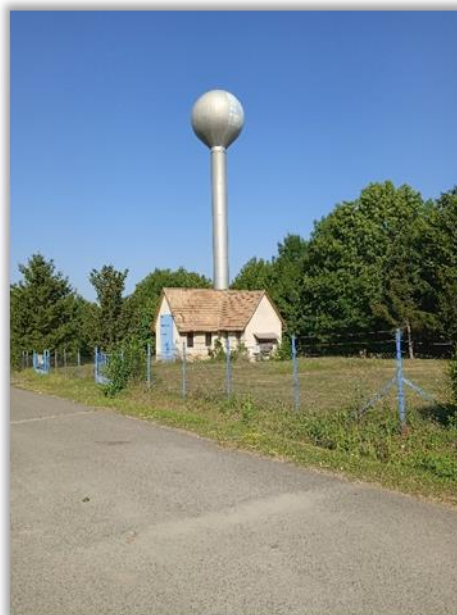
8. ábra Vízműház a glóbuszal (saját fotó)
