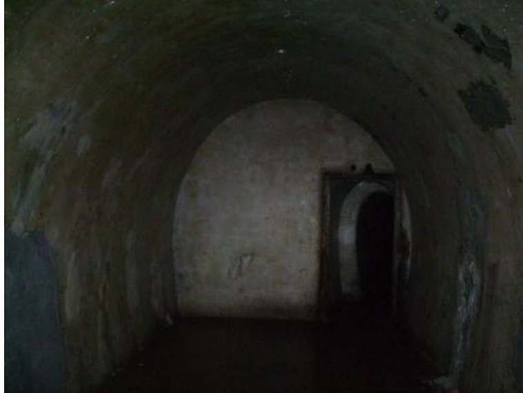
10. kép: Ugyanez a bunker belülről. Hatalmas kiterjedésű! (Forrás: saját kép)
