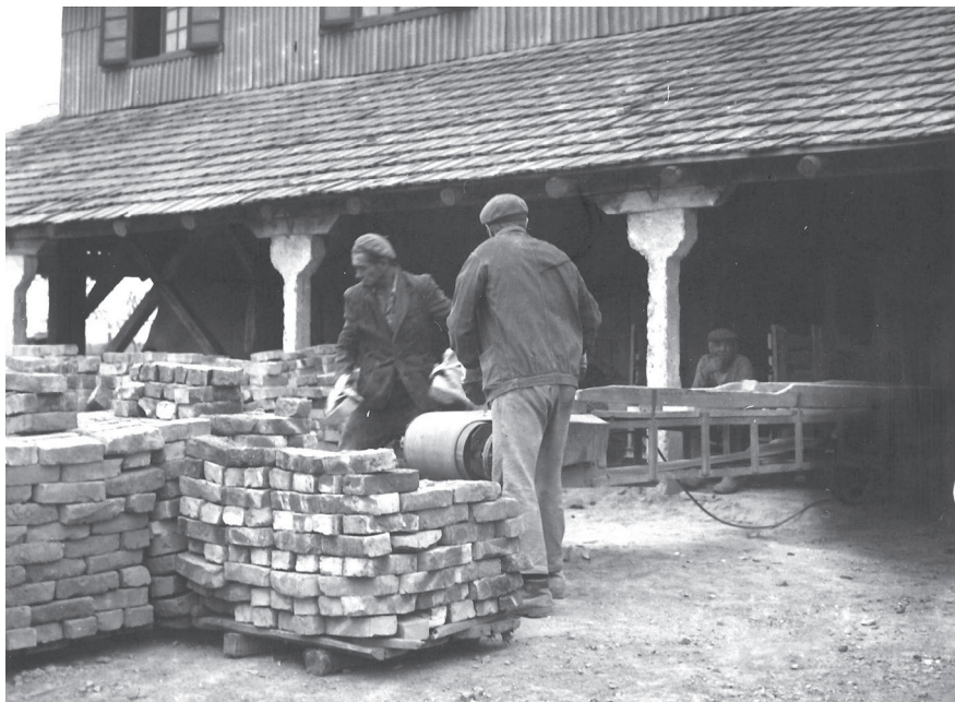
12. kép. Téglapakolás az égetőkemencékből (Csatóerdő, téglagyár) 292
