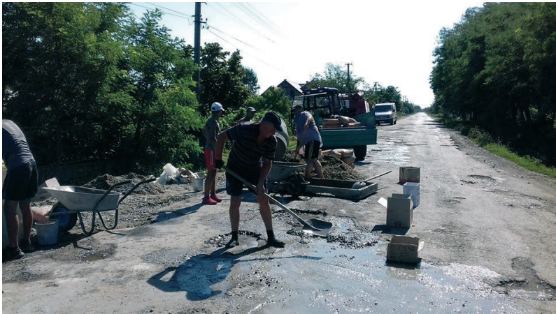
26. kép. Nagypálfa, 2019. A lakosok javítják (betonozzák) a faluból kivezető főutat 462
