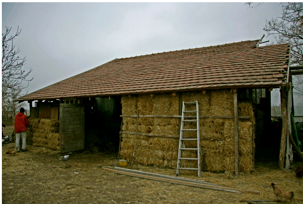
Istálló szalmabála hőszigetelése. 2011, Gátér. Fotó: Holczer Veronika
