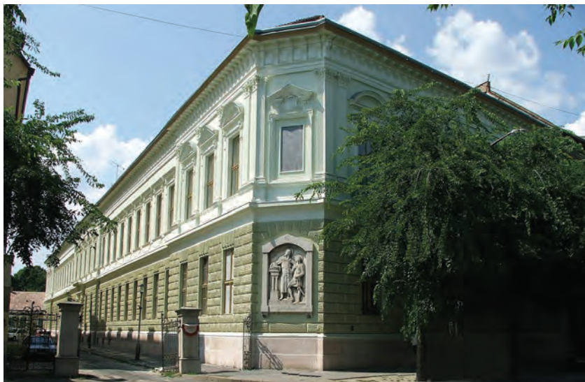
A Bencés Gimnázium épülete a Kossuth Lajos utca felől
