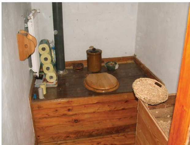
23. ábra: Falazott beltéri komposzttoalett, saját tervezés. (A szerző felvétele.)
