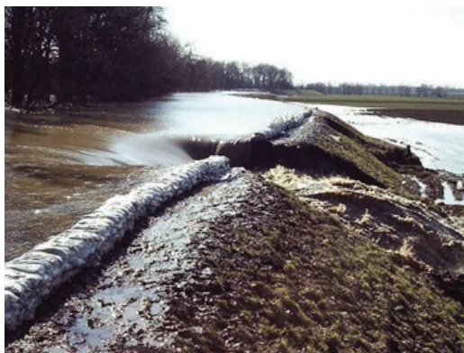
17. ábra: A Tisza töltésének átszakadása Tarpánál 2001 nyarán. (Forrás: Bodnár, 2009)
